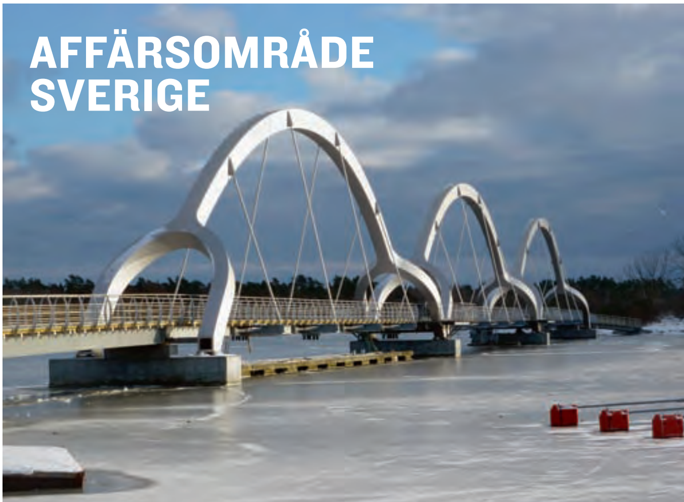
Den vackra Sölvesborgsbron är byggd av 150 ton duplexstål levererat av BE Group.
